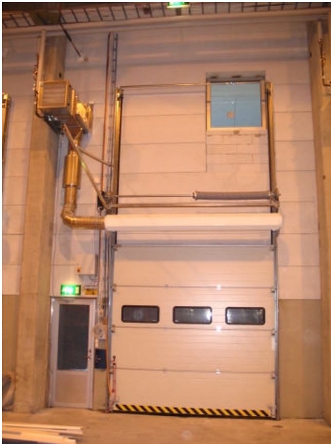
Kuva 1. MVP-S 315 laitteisto lämmityksellä ja 2-nopeuskeskuksella kuormaustilan yhteydessä. Hallin lämmitys tapahtuu pääosin näillä laitteilla.
