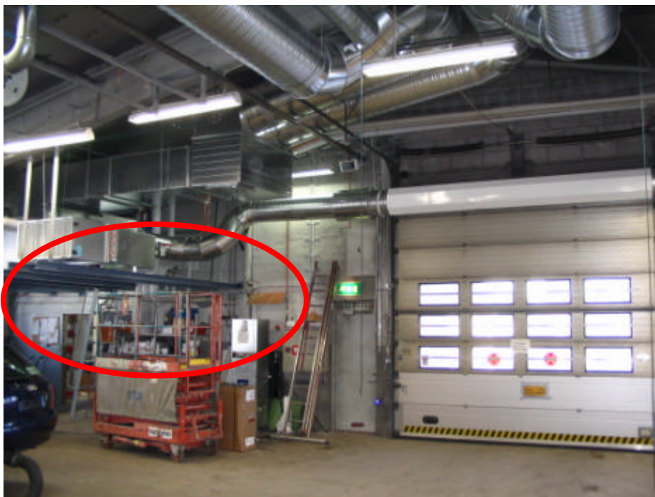
Kuva 17. Esimerkki puhallin + patteri+ suodatinyksikön kannatuksesta
