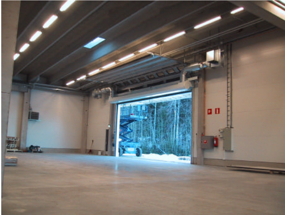
Kuva 21. Teollisuushallin ovi, leveys 8m ja korkeus 4m. Laitteina 2 kpl MVP-S 450, ilman lämmitystä, sijaitsee Lahdessa
