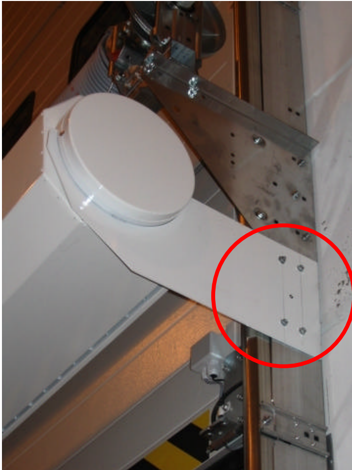
Kuva 23. Suutirummun kiinnitys ovi kiskoon
