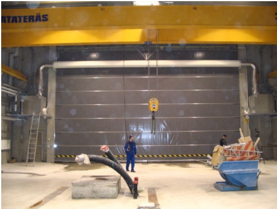
Kuva 22. Teollisuusoviaukko leveys 12m, korkeus 6m. Laitteina 2 kpl ylhäältäpuhaltavia MVP-S 535- 15 kW, varustettuna vesiapatterilla. Sijaitsee Pohjois-Karjalassa
