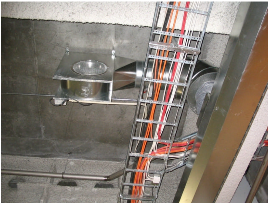
Kuva 20. Tunnelin katon ilmasulun puhallin (yhteensä 3 kpl)
