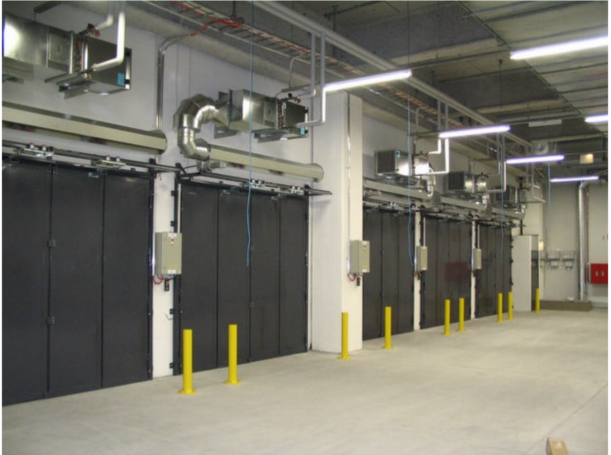
Kuva 18. Ylhäältä puhaltavia MVP-S 315 lämmityksellä
