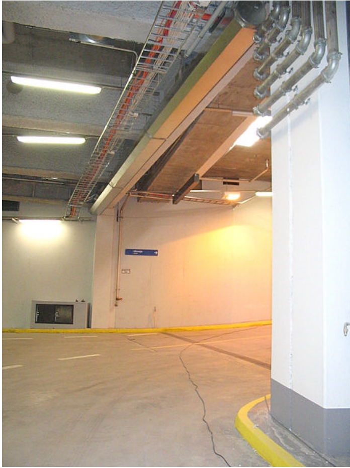
Kuva 19. Ilmasulku tunnelin katossa
