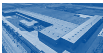
Hörmann Tianjin, Kiina
