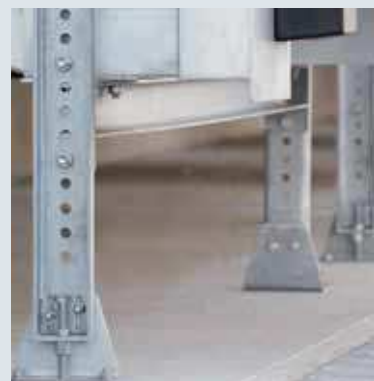
Säädettävät perustusjalat Perustuksen tasoa voi sovittaa korkeussuunnassa säädettävien tukien ansiosta myös jälkikäteen (esim. rakennuksen vajotessa). Teräslaiturin jalat toimitetaan yleensä sinkittynä.
