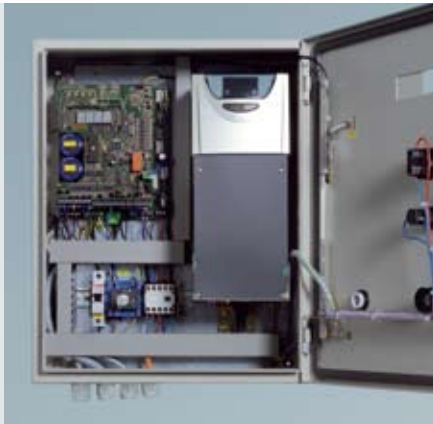
Ovi aukeaa automaattisesti varavaimalla (UPS). Avaa oven sähkökatkonkin sattuessa.
