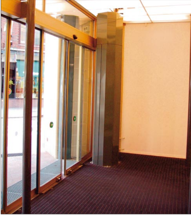
InterSport Megastore, Helsinki. Kompakti-ilmassulku, jossa on sisäänrakennettu puhallin ja vesipatterilämmitys. Rummun väriksi voidaan valita mikä tahansa RAL-värisävy.
