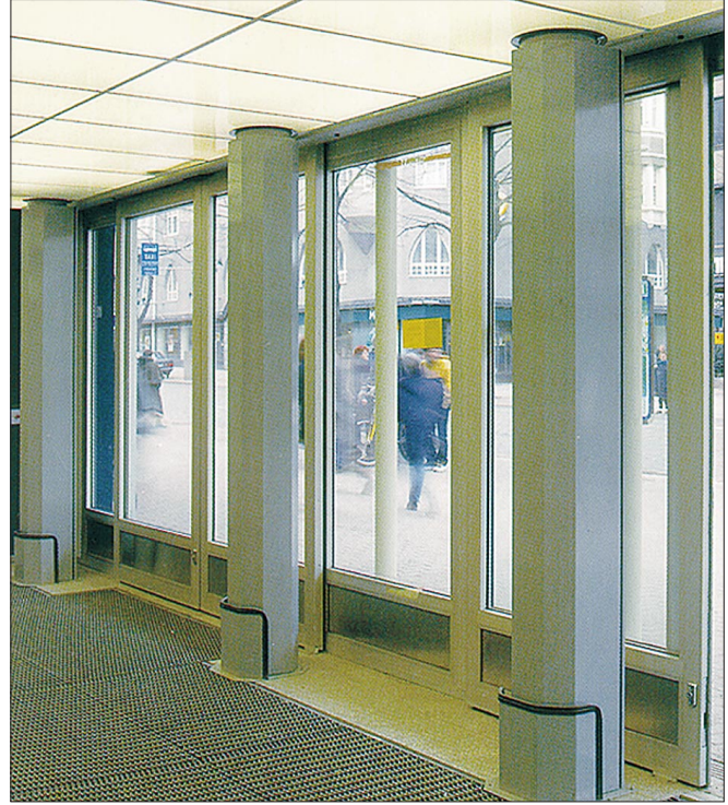
City Sokos, Tampere. Tavaratalon pääsisäänkäynti varustettuna Mesvac-ilmassululla. Ilmasuluissa vesipatterilämmitys ulko-termostaattiohjauksella. Ilmasulut käynnistyvät ja pysähtyvät ovien avautumisautomaatiikan ohjauksella.
