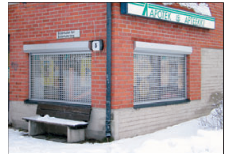
Testatuilla ja luokitelluilla murtosuojuilla saa- daan luotettava suojaus. Malli 3560, luokka 2, Söderkullan apteekki, Sipoo.
