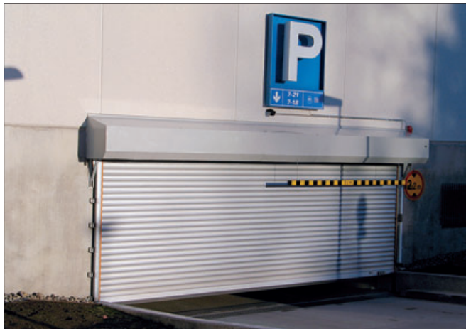
Mesvac Hörmann malli Decoterm soveltuu mainiosti kauppakeskusten puoiliämpimien parkkihallien oviksi sekä varastojen ym. eristetyiksi oviksi. Malli Decoterm, Eurospar Kaivoksela, Vantaa.
