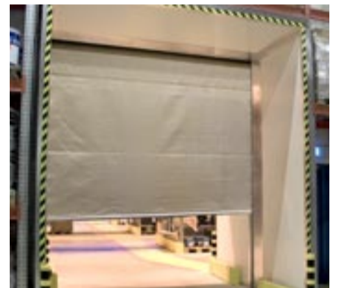
Normaalioloissa palorullaovi E120 on kotelossa oven yläpuolella. Sen etu on keveys ja kustannustehokkuus, kun taas paloliukuovi on raskas, tilaavievä ja kallis.
