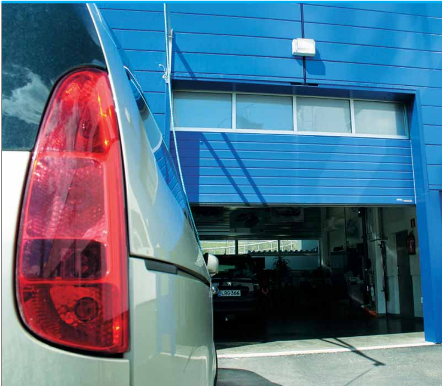
Automaa Helsinki sai viime kesänä uuden siiven. Laajennuksen alaosaan rakennettiin nykyaikainen Diag-klinikka.
