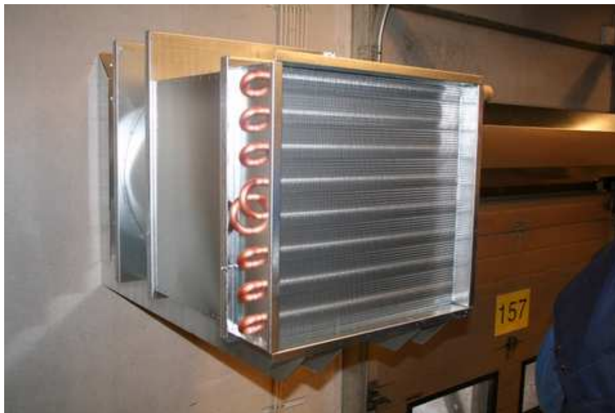
Kuva 8. Vesipatterin asennus
