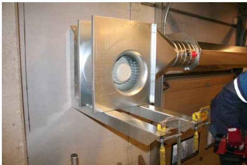
Kuva 6. Puhaltimen asennus
