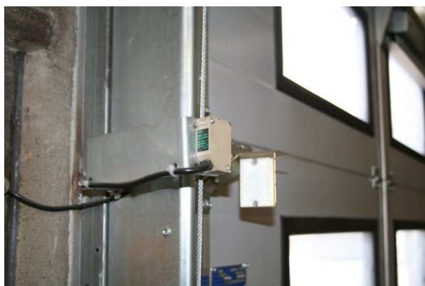
Kuva 11. Valokenno-oviraja asennettuna, valokennon asennus
