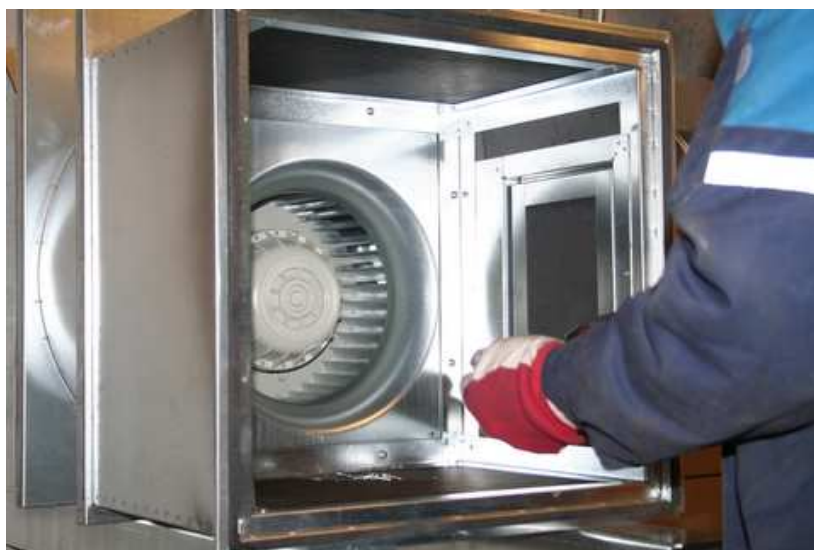
Kuva 7. Muuntoyhteen asennus
