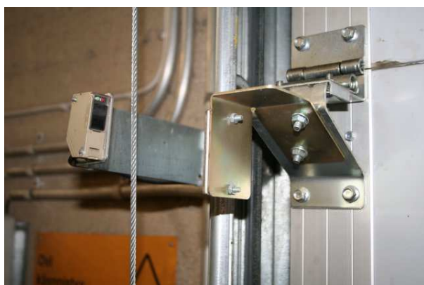
Kuva 12. Valokenno-oviraja asennettuna, peilin asennus
