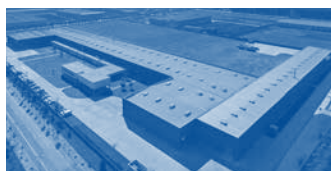
Hörmann Tianjin, Kiina
