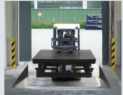
Aseta uusi kuormaussilta paikoilleen
