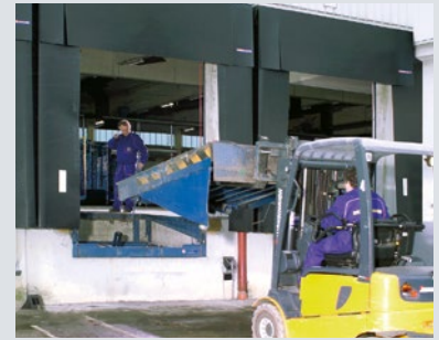
Irrota vanhat kuormaussillat, sovita mahdollinen monttu (esim. asennuslevyillä tai konsoleilla)
